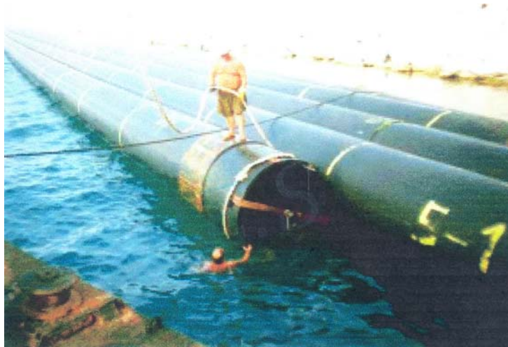
شکل شماره ۵- انبار نمودن مقاطع لوله روی سطح آب
