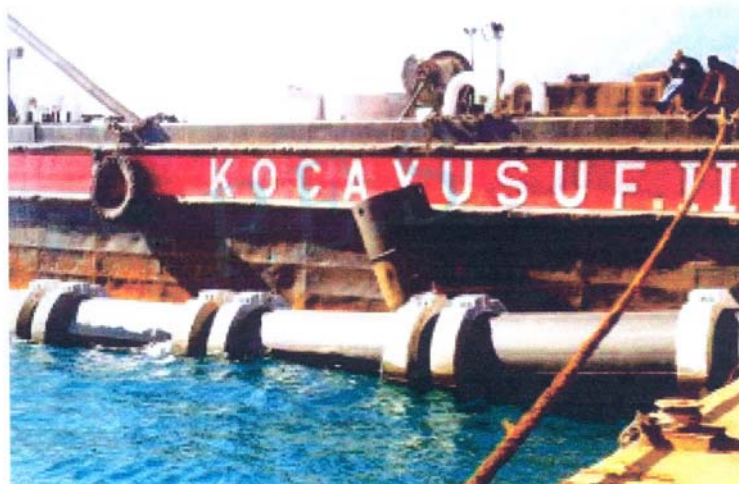
شکل شماره ۶-وزنه‌های بتنی روی لوله ثابت شده، کل خط لوله در سطح آب شناور می‌گردد
